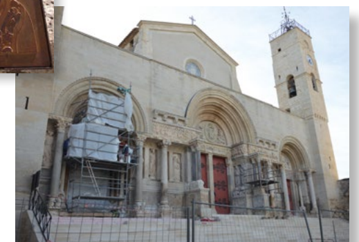
Restauration de l'abbatiale Saint-Gilles
